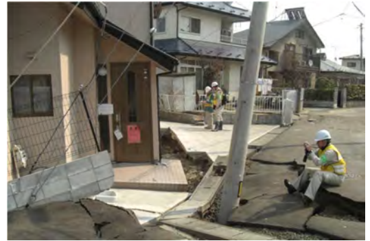
図表-3 被災建築物応急危険度判定状況
