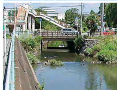
整備前は、上下流の河川断面に比べて、橋梁部が狭くなっていた。
