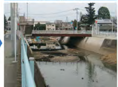
橋梁部の川幅を拡幅する改修を実施した。
