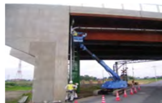
(主) 伊勢崎深谷線 境木島跨線橋
