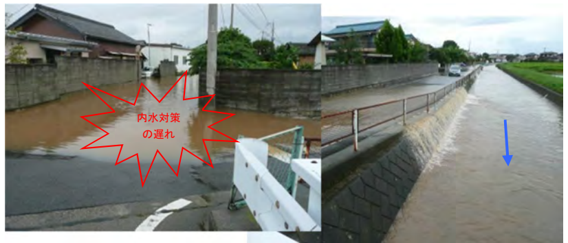
図表-47 H23.9の蕪川付近での内水被害状況（伊勢崎市）
