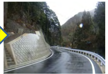
コンクリートの構造物で道路を広げ、緊急時にも安全な通行を確保
