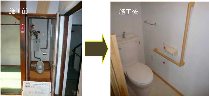
図表-74 住宅のバリアフリー化の施工例
