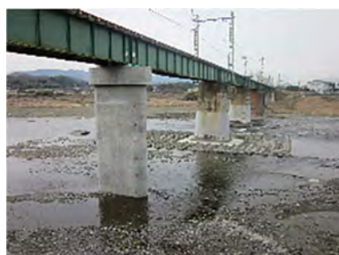
老朽化橋脚の更新【上信電鉄】
