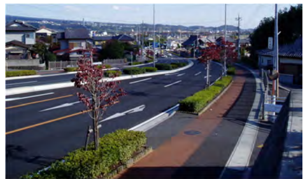
終点側より(主)高崎渋川線との交差点を望む
