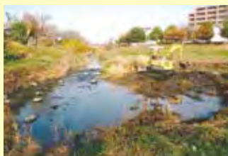
牛池川の保全改修工事
