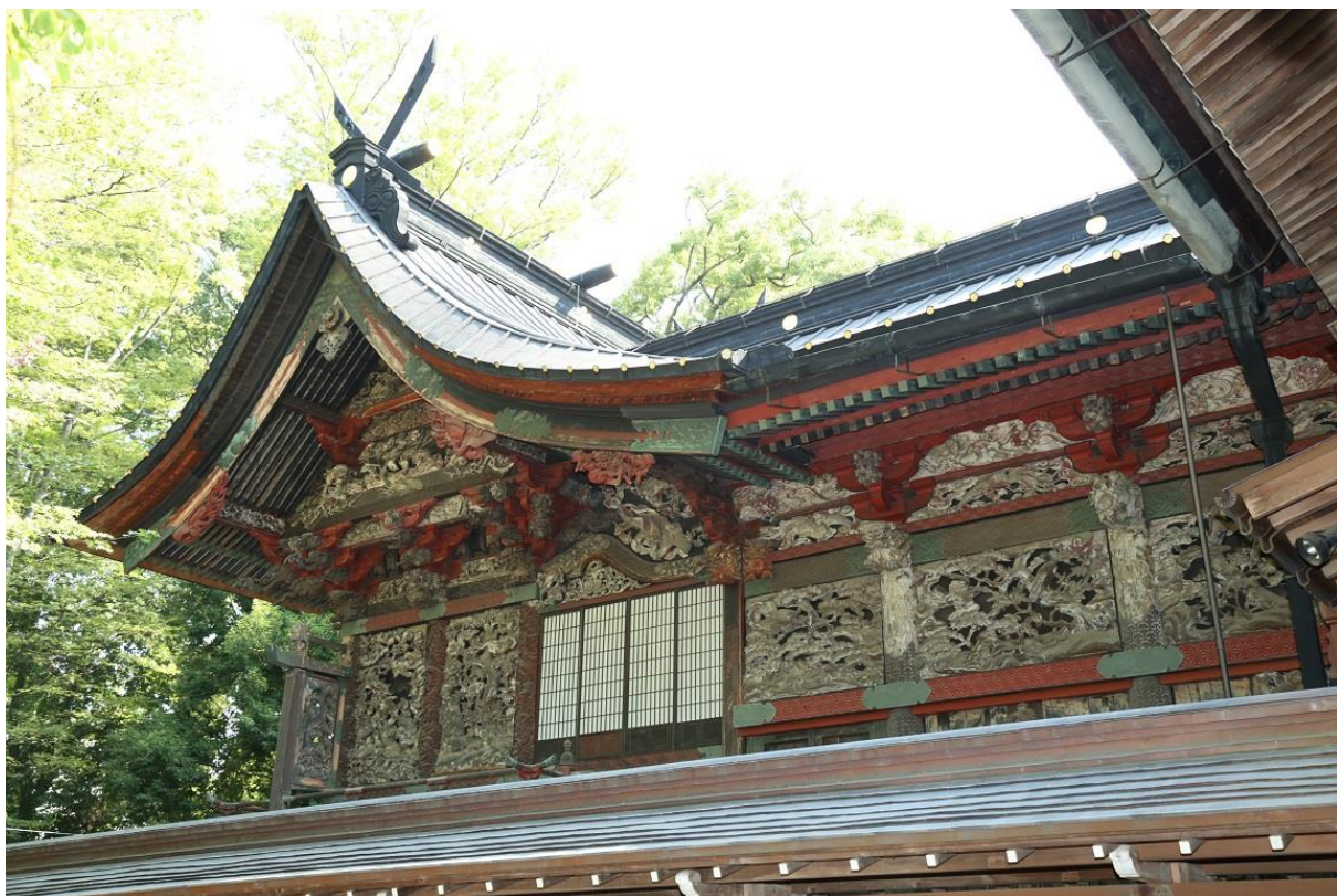
2 天満宮 本殿・幣殿 (側面) 西から (群馬県提供)
