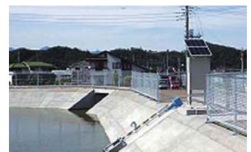
防災重点ため池の耐震化を図る 防災・減災対策
