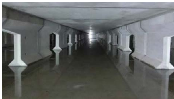
貯留施設（駒形町雨水調整池（前橋市））
