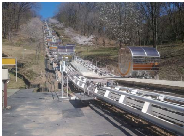
老朽化した大型遊具の補修(パノラマチェア) (令和2年3月一部完成)
