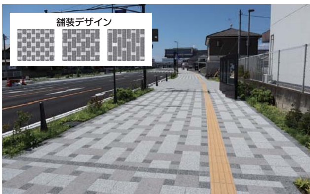
織物を意識したインターロッキング舗装 （（都）コンベンション施設北口線 高崎市内）
