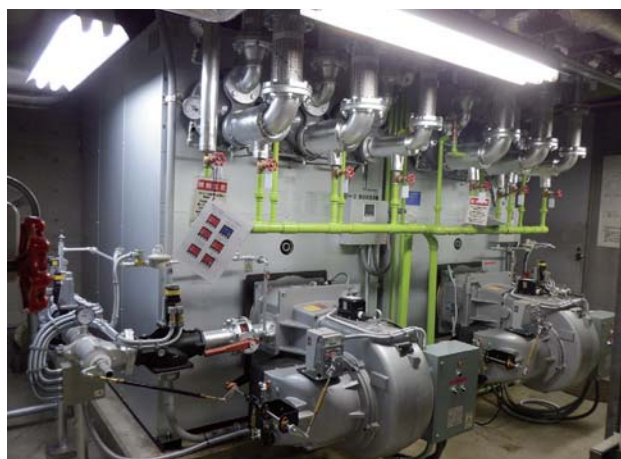
水泳場ボイラー更新 (令和元年12月完成)
