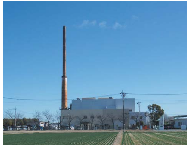
玉村町クリーンセンター（ごみ焼却場）(玉村町)
