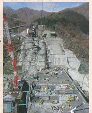
工事が進むハッ場ダム本体
