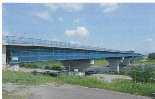
建設中の(主)寺尾藤岡線バイパス(仮称) 新鐮川橋(平成30年8月現在)
