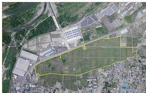
工業団地造成が始まる 藤岡インターチェンジ西産業団地
