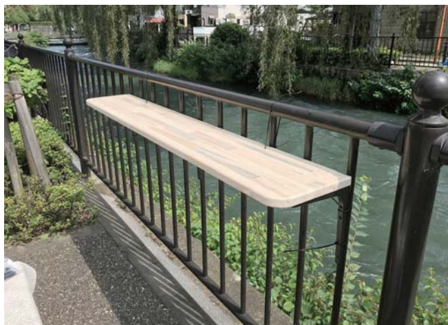
既存手摺に取り付けたカウンター
