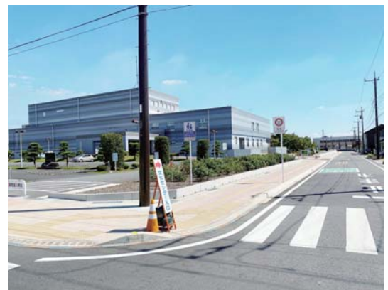
インターロッキングブロック舗装
