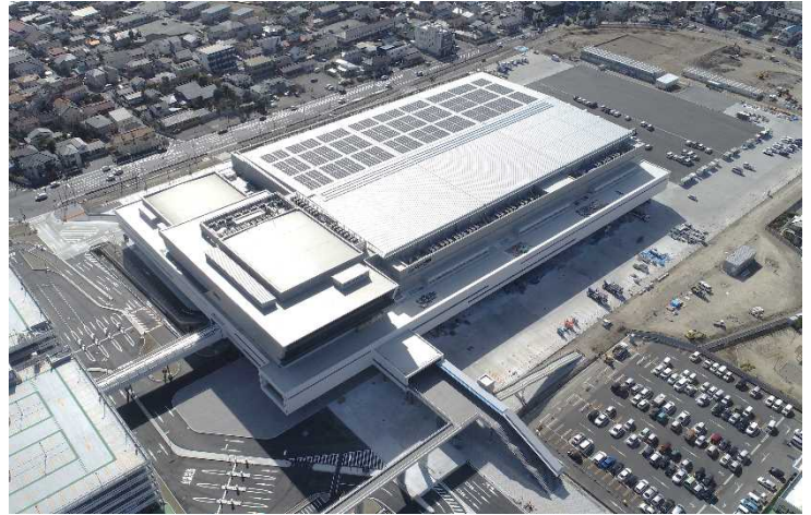
△ 敷地上空からの工事の様子（会議・展示施設）
