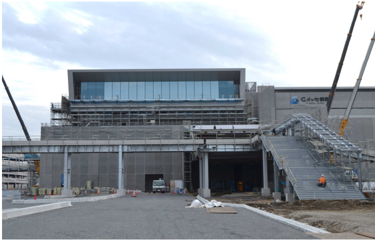
△ 会議施設北面の工事の様子
