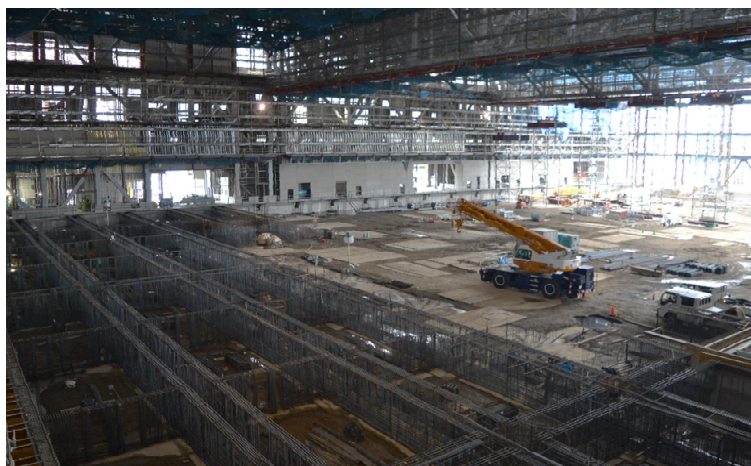
△展示ホールの床工事の様子
