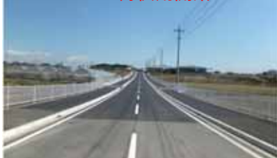
【ローズタウン中通り線2期工区】 H23.4月供用開始
