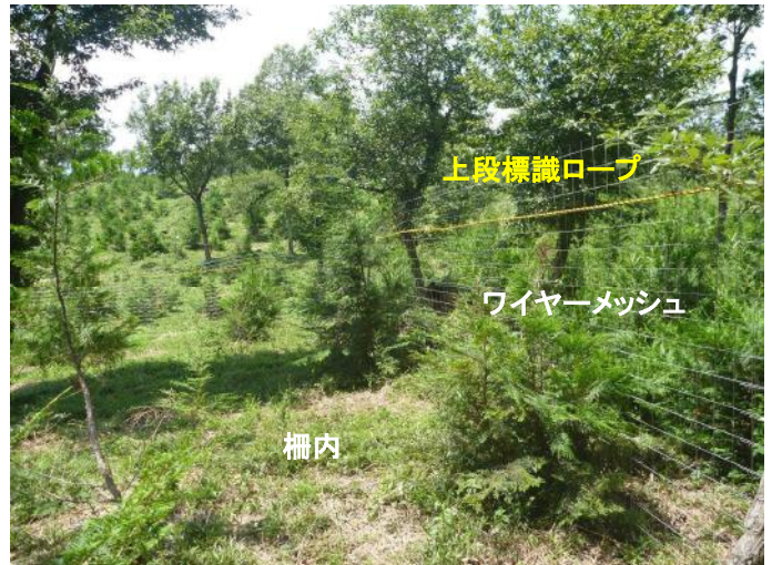
図-3 標識ロープとワイヤーメッシュの設置
