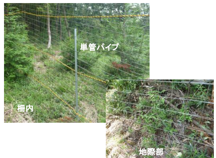
図-5 単管パイプの設置と地際の状況
