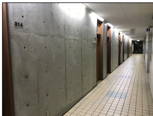
写真左は3号館 1F 教室前の廊下です。
