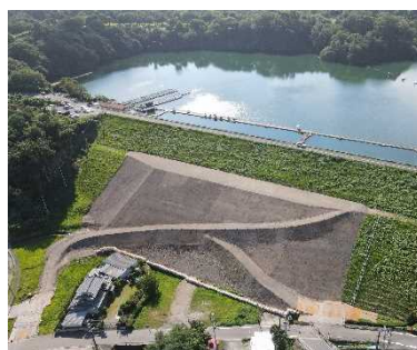
貯水池における耐震補強工事
