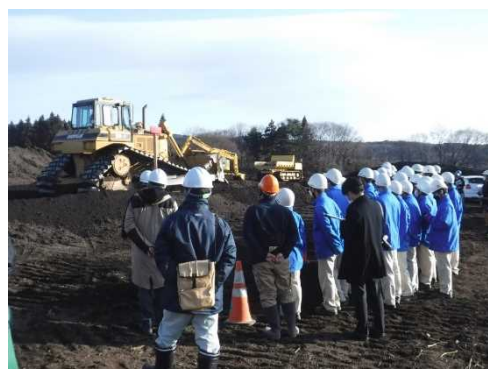
現場見学状況
