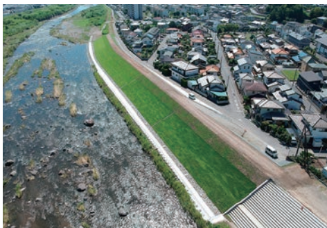
▲ 一級河川碓氷川の河川改修
