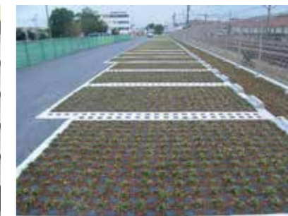
景観パーキング (舗装に変わる砂利用・芝生用地盤安定材使用の駐車場)
