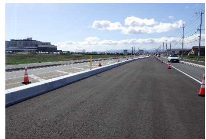
整備中の状況（前橋赤十字病院付近）
