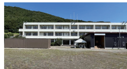
旧上白井小学校に設置した栽培用設備等
