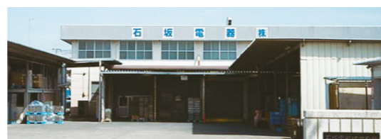
石坂電器本社工場
