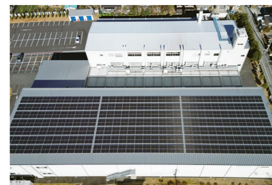
ミツバ様赤城工場の太陽光発電設備
