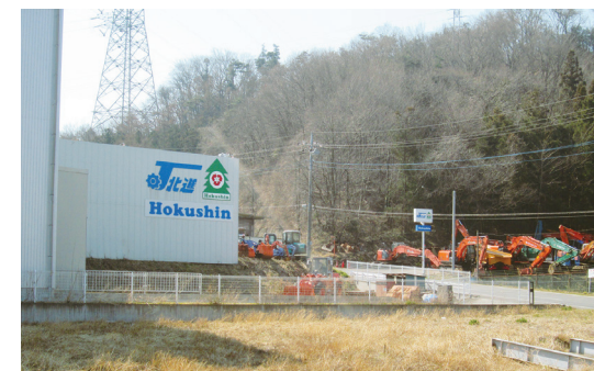
第三リサイクル工場（解体材）
