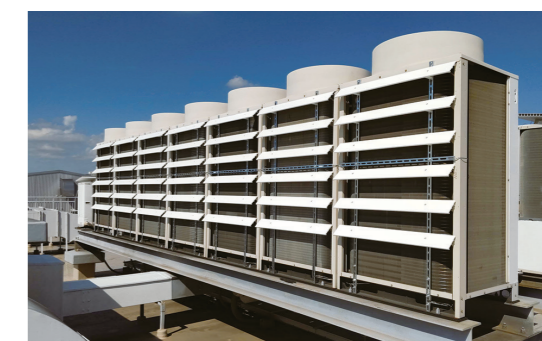
室外機省エネ節電対策の様子
