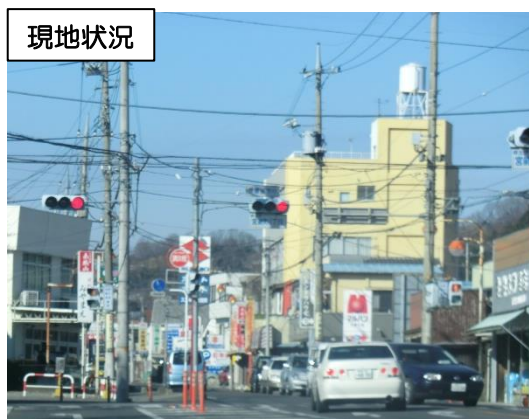
乱立する電柱・電線類
