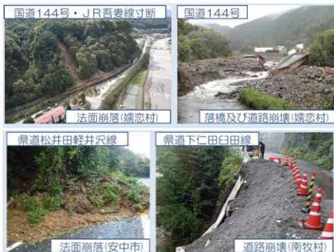
令和元年東日本台風による被害状況（道路寸断）
