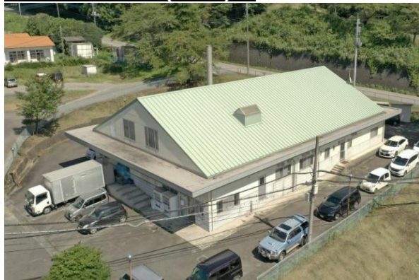
要配慮者利用施設(管理棟)
