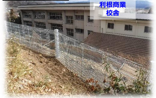
防護柵工施工
