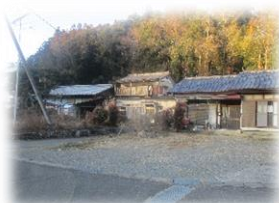
保全対象（人家）
