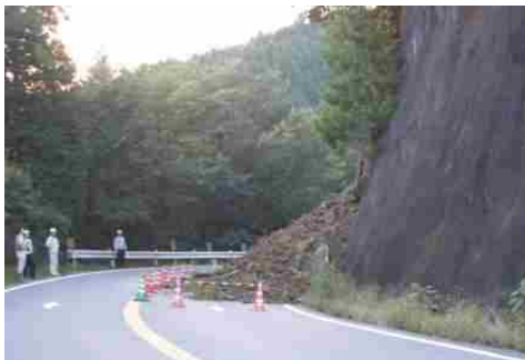
国道145号斜面崩壊
