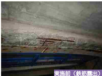
実施前（鉄筋露出）
