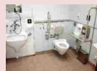
高齢者・障害者対応トイレ
