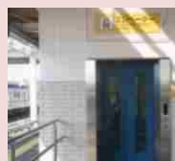
エレベーター設置
