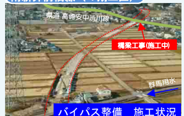
バイパス整備 施工状況
