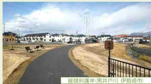
緩傾斜護岸(男井戸川 伊勢崎市)
