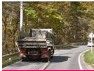
国道144号幅員狭小状況
