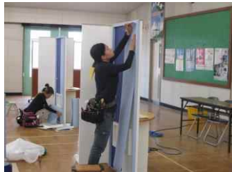
技能検定(内装仕上げ施工)
