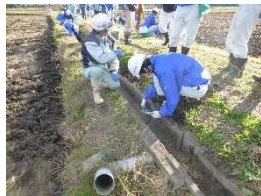
水路簡易補修
