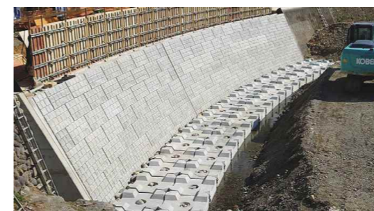
大型護岸ブロック
