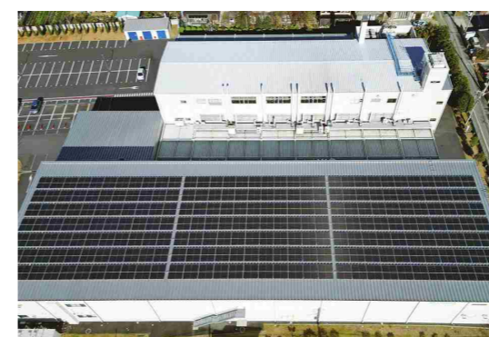
ミツバ様赤城工場の太陽光発電設備
