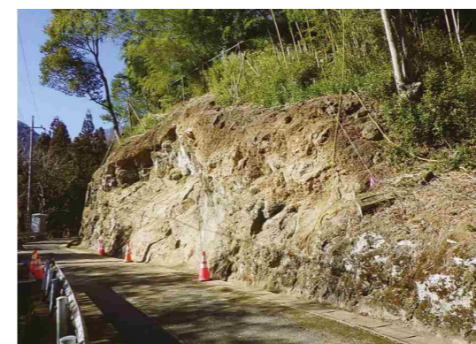
タフネスフォーマー工法（吹付） 施工前
