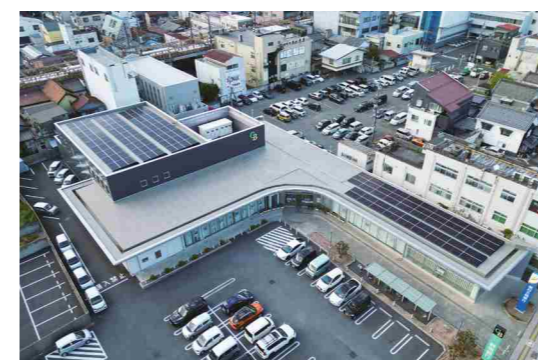
群馬銀行高崎田町支店の太陽光発電設備
