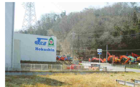
第三リサイクル工場（解体材）
