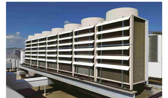
室外機省エネ節電対策の様子
