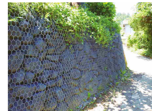
タフネスフォーマー工法（石積み補強） 施工完了
