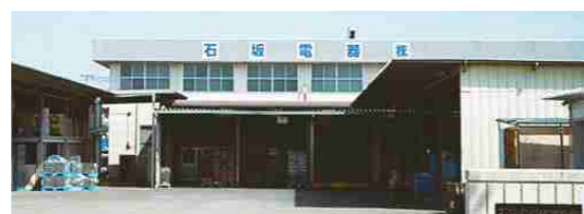
石坂電器本社工場
