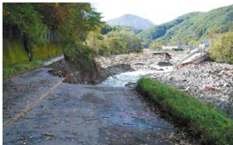
国道144号 鳴岩橋（嬬恋村）
