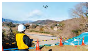
ドローンを活用した災害調査
