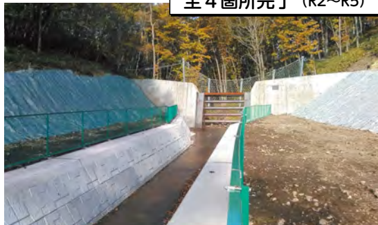
▲ 女塩淵沢 土石流対策 ▲
