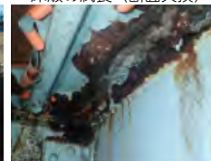
床版の腐食（断面欠損）
