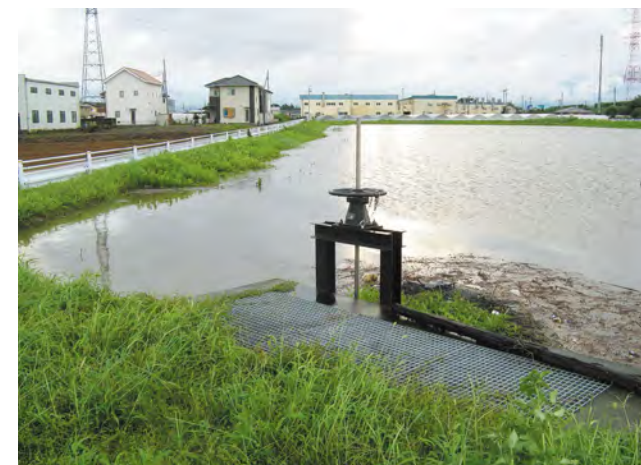
雨水貯留状況
