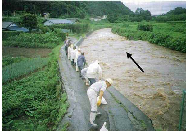
山田川 桐生市川内地先「積土のう工」により越水を防ぐ
