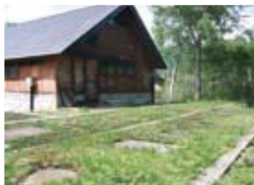
△ 公衆トイレ裏の合併処理浄化槽
