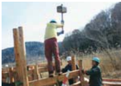
③ 木道工事は手作業で行う
