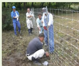
(侵入防止柵の設置)
