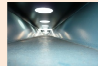
設置後の屋根面
