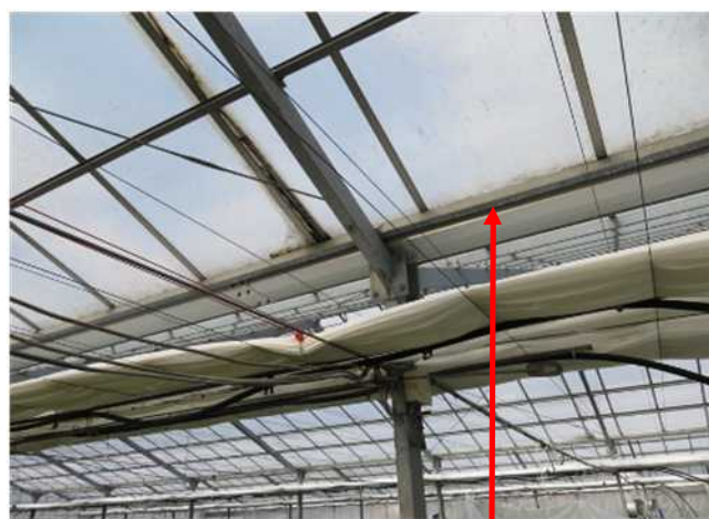
【 谷樋の両側をC鋼で補強 】
