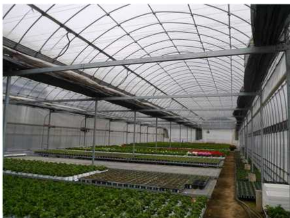
【 母屋パイプによる小屋高部の補強 】
