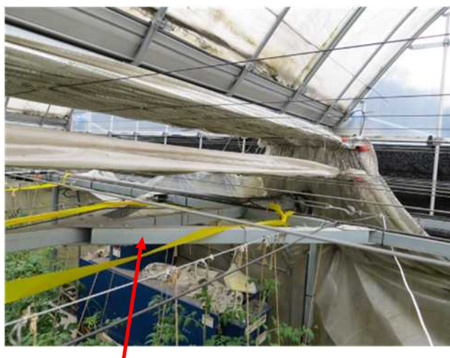
【 横ばりの補強 (50 mmの角パイ) 】
