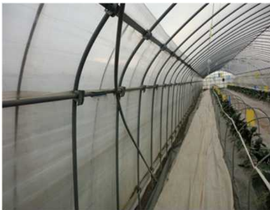
【 ハウス側面の両側の筋交い 】
