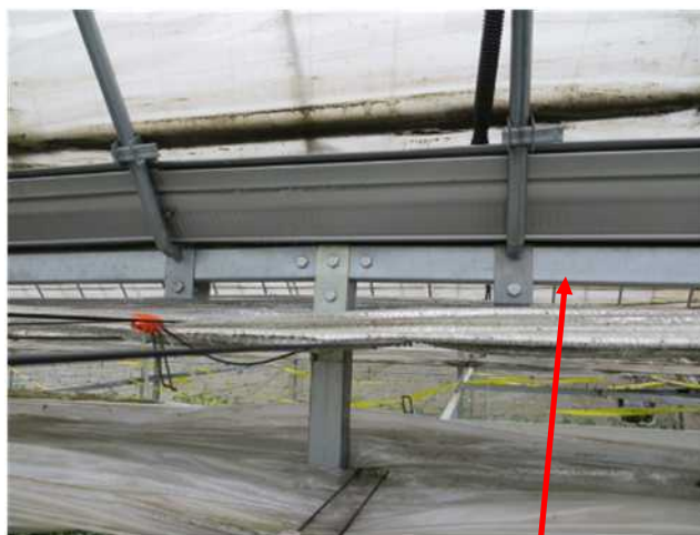
【 谷樋下を補強 (50 mmの角パイ) 】
