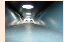
設置後の屋根面
