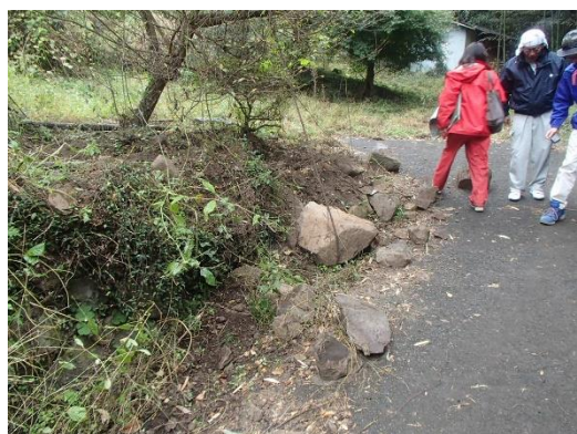
C: 道路法面の掘り起こし
