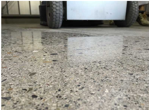
コンクリート鏡面仕上げ
