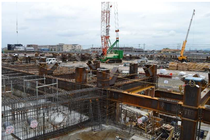
△ ①地下構造部の鉄骨工事及び鉄筋工事の様子
