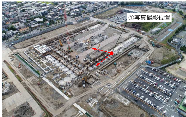
△ ②敷地上空からの工事の様子
