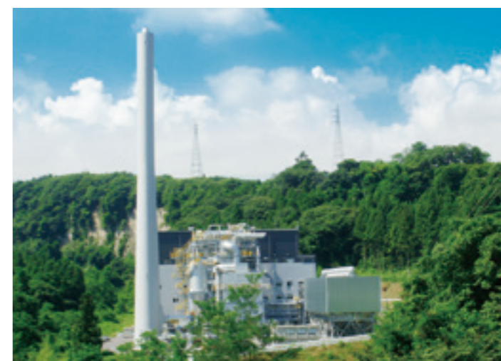
吾妻木質バイオマス発電所(東吾妻町)
