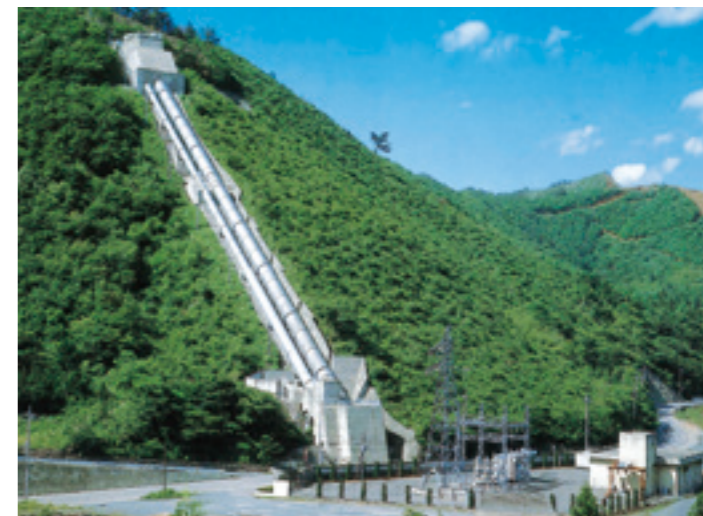
県営の水力発電所 小平発電所(みどり市)
